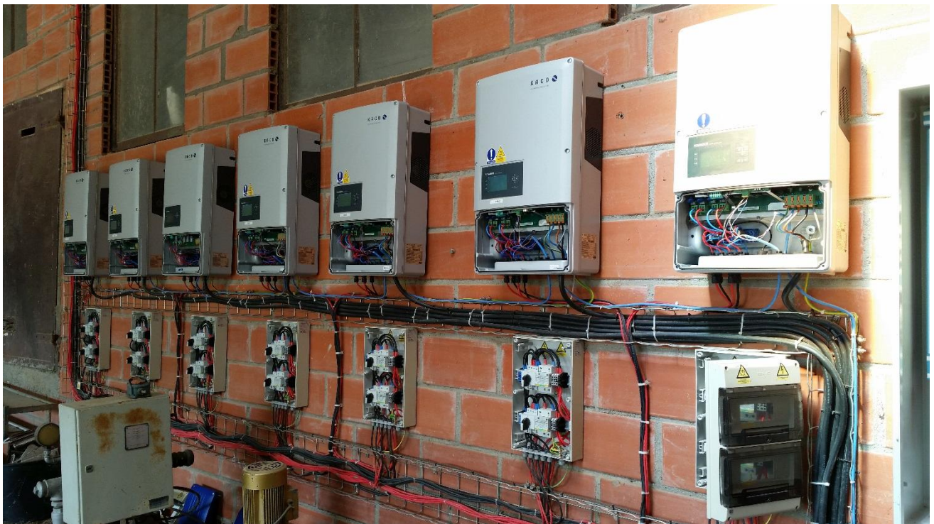
Figure 5 : Ouverture des onduleurs et des coffrets DC après le nettoyage pour les différentes prises de mesures.
