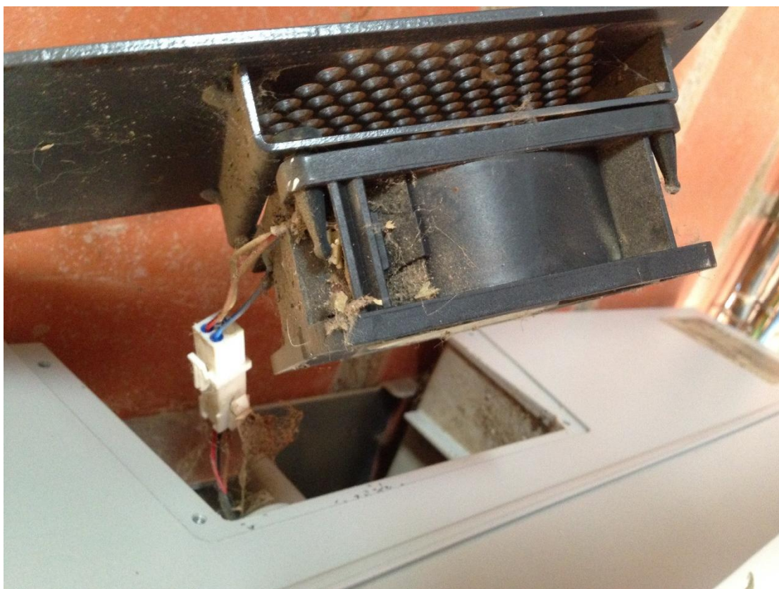
Figure 4 : Nous avons nettoyé les ventilateurs des onduleurs.
