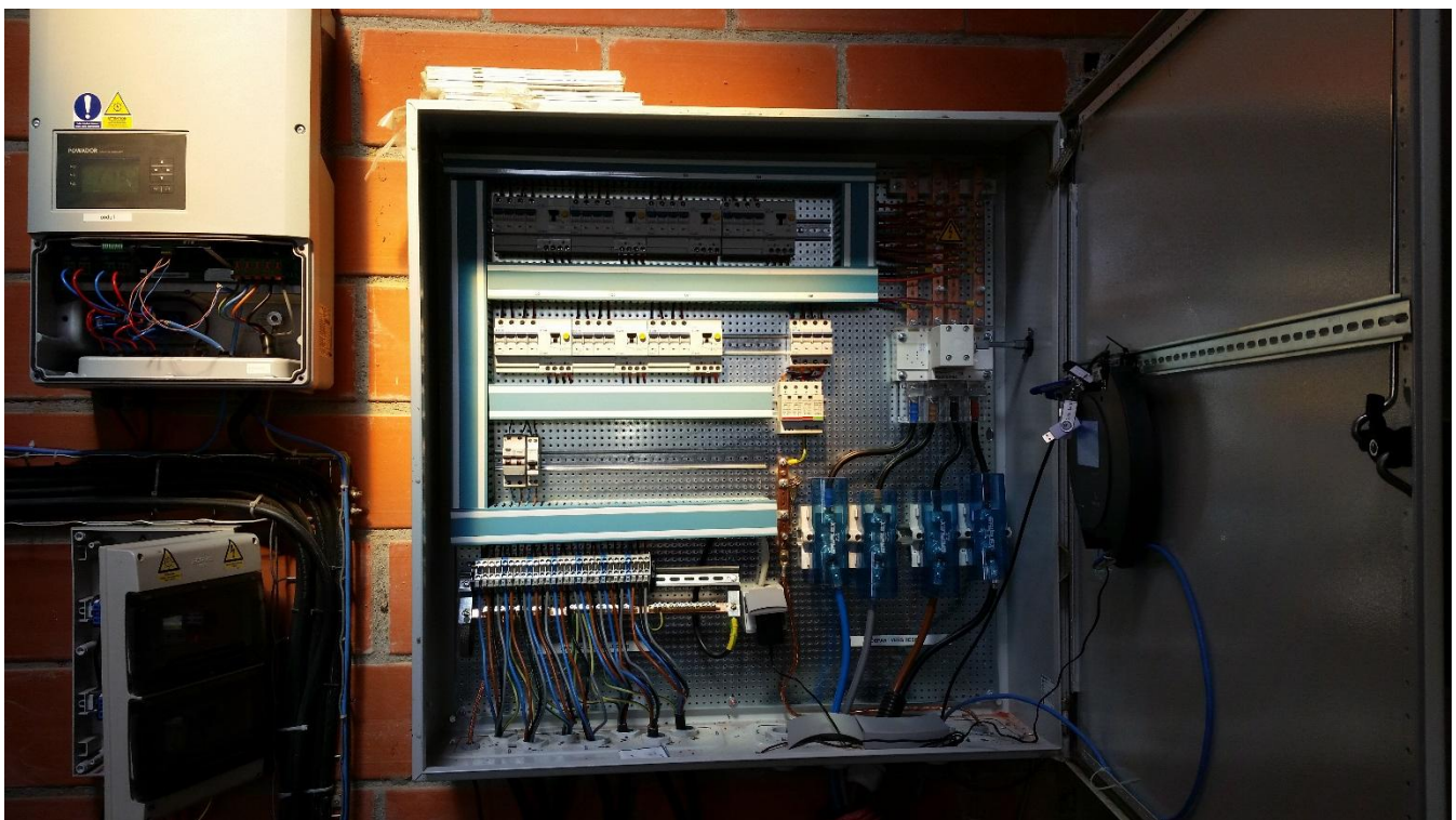
Figure 5 : Ouverture des onduleurs et des coffrets DC après le nettoyage pour les différentes prises de mesures.
